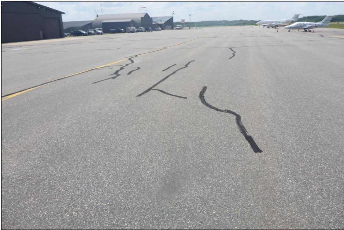
INL APB 001 (PCI = 77)
